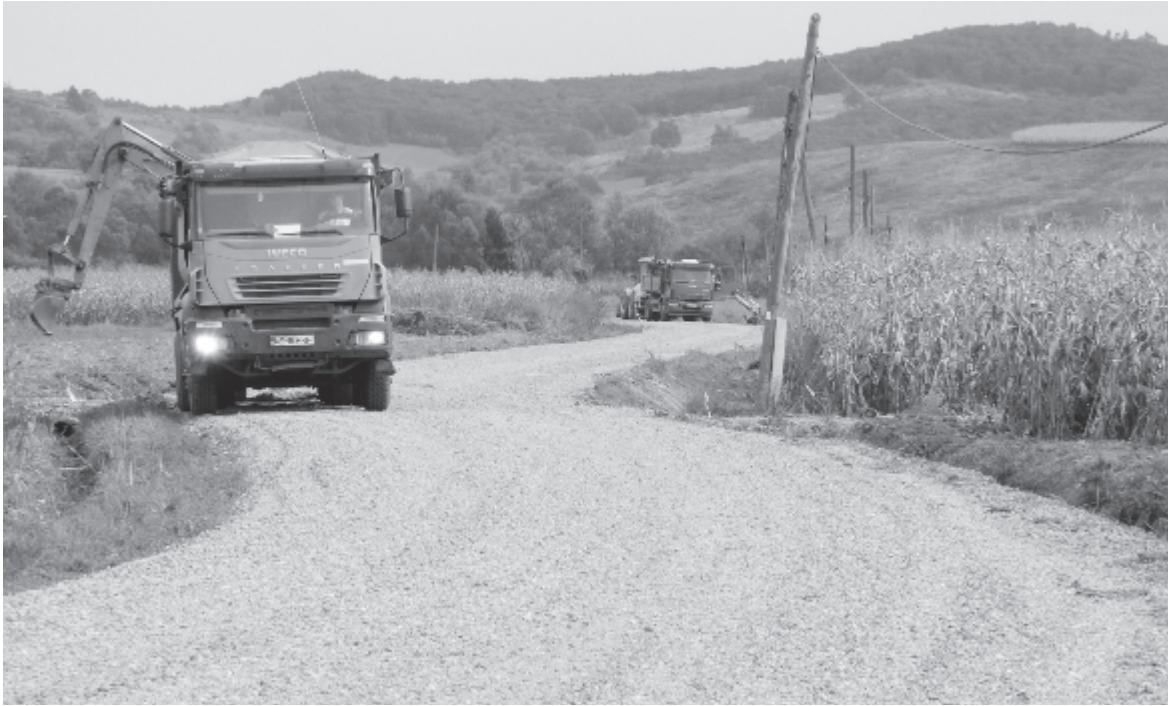
Javában folyik az útalapozás, hamarosan az alapréteget is lefektetik Kisadorjánig
